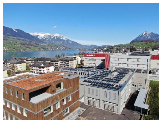
PV Anlage auf dem Gebäude der bio-familia
